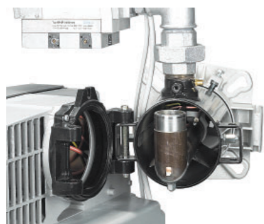
Ispezione testa di combustione
